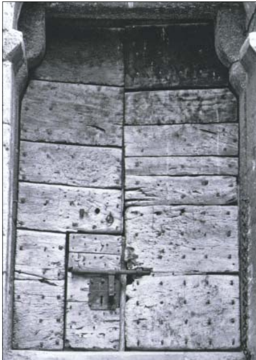
3. Vantaux de la porte du donjon de Crest (Drôme - XIV e siècle). Ici les planches horizontales sont en parement ; le guichet est fermé par un très grand coureil (5) .
