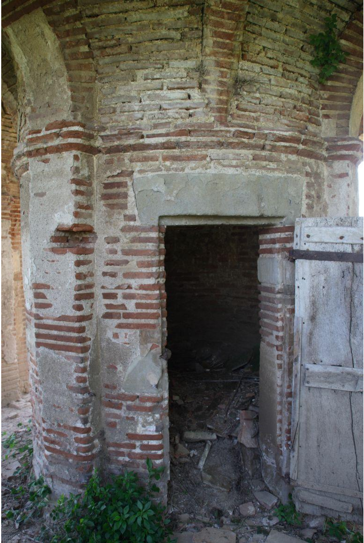
Le pilier central qui abritait l'escalier montant a l'étage
