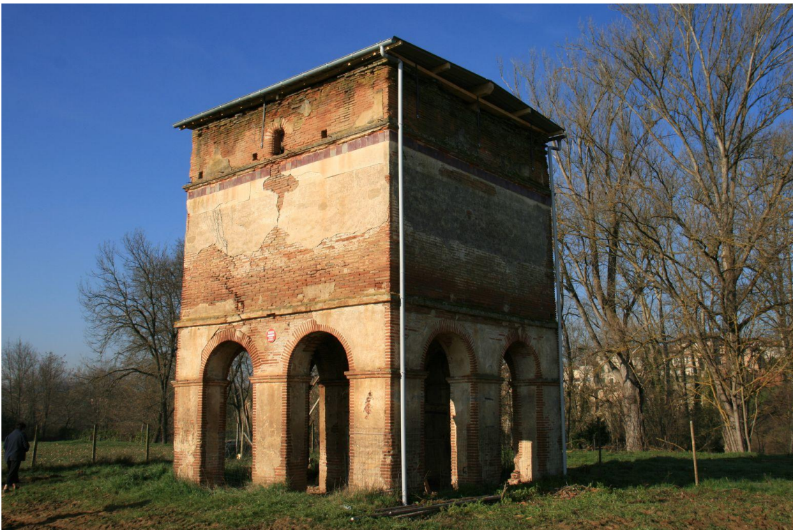
Une première opération a permis de mettre le pigeonnier hors d'eau en le protégeant d'une toiture temporaire faite de solides poutres et une couverture en tôles ondulées. Le toit avec une faible
